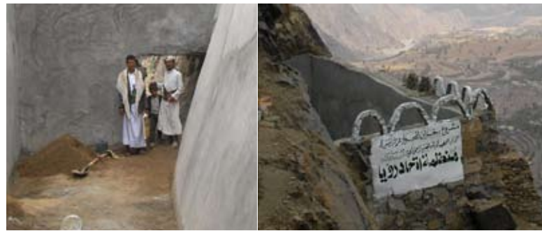
Zisternenbau in Al Mahwar
