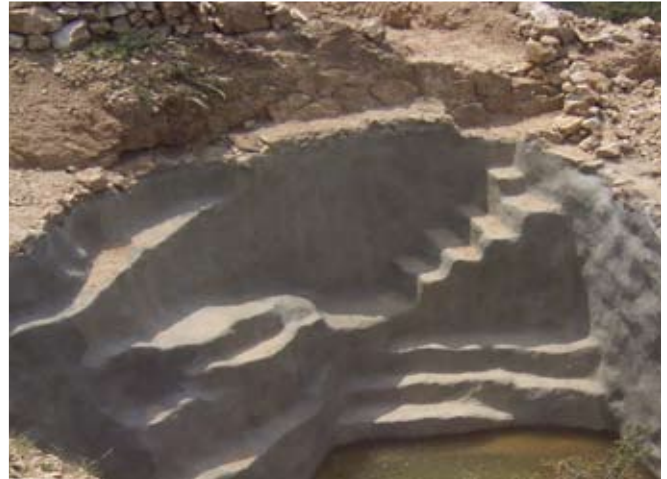
Sanierte Zisterne - hier stecken ca. 1.500 Arbeitsstunden der Dorfbevölkerung drin!
